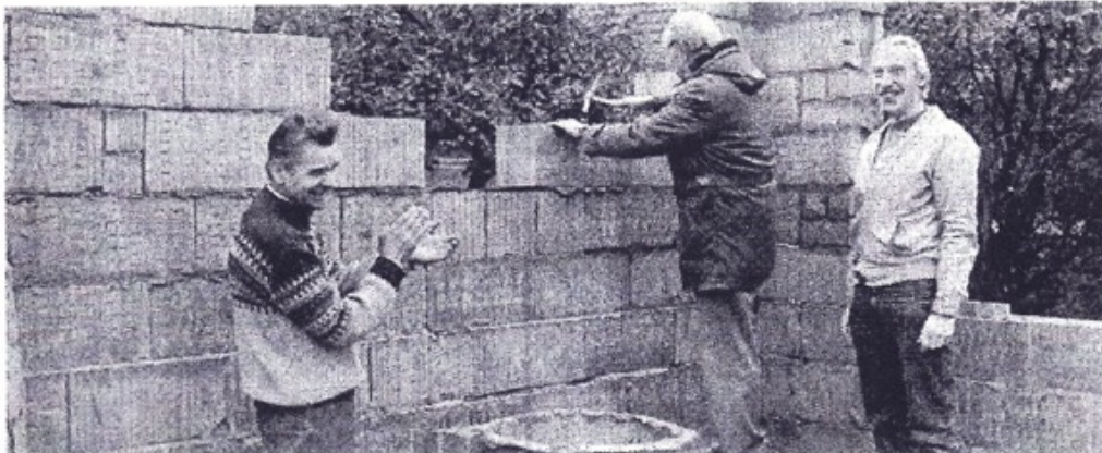
Bürgermeister Horst Heine (Bildmitte) legte den Grundstein für den neuen Schießstand des Schützenvereins Rickensdorf an ehemaligen Kindergarten. Der Vorsitzende Manfred Beckmann (rechts) freut sich sichtlich. Foto: Schulz
