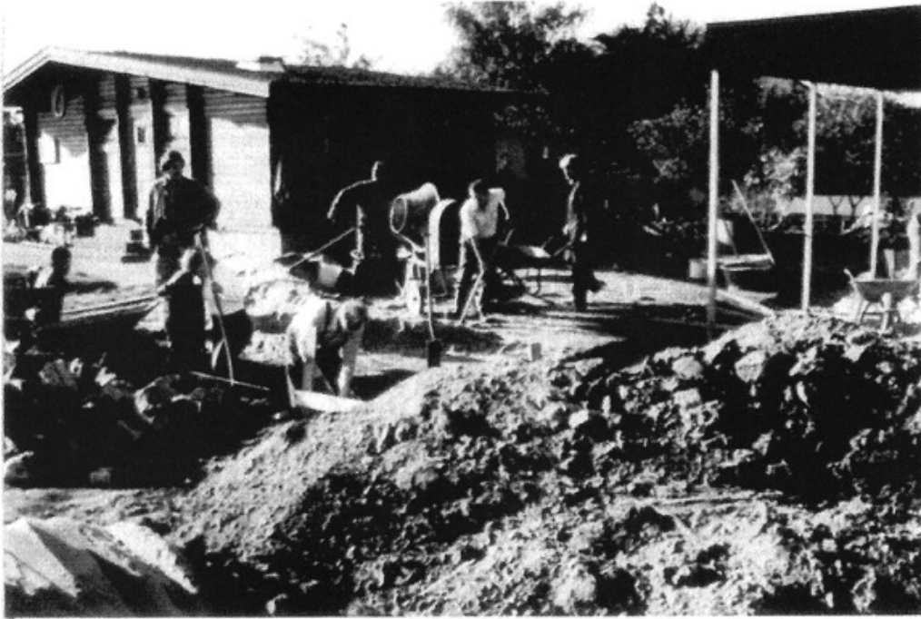
Ein halbes Jahr später sorgten die vielen Helferinnen und Helfer dafür, dass nach 7.021 Arbeitsstunden die Einweihung gefeiert werden konnte.
